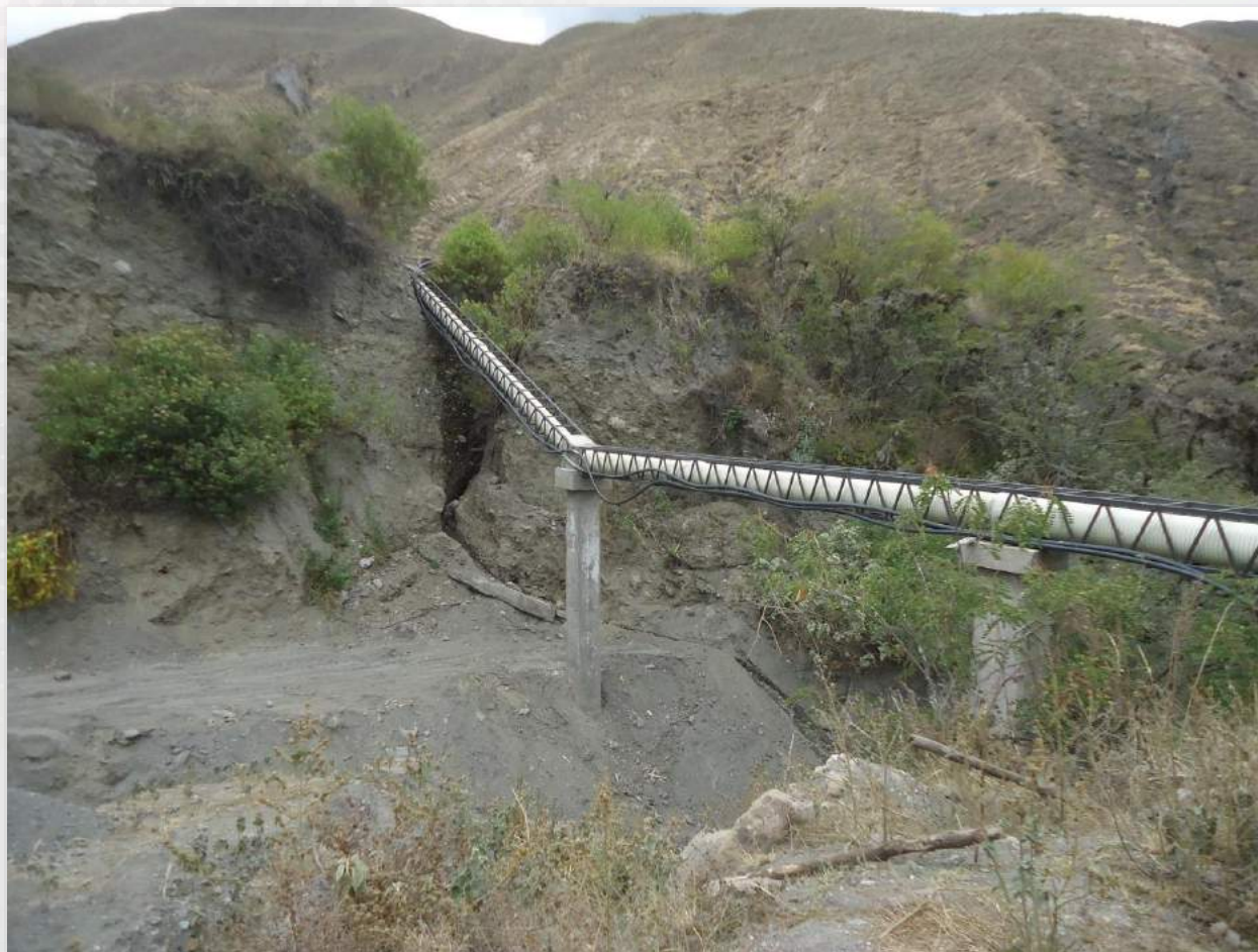
PASO ELEVADO EN QUEBRADA SIN NOMBRE, ACEQUIA EL QUICHE - AMBUQUI
