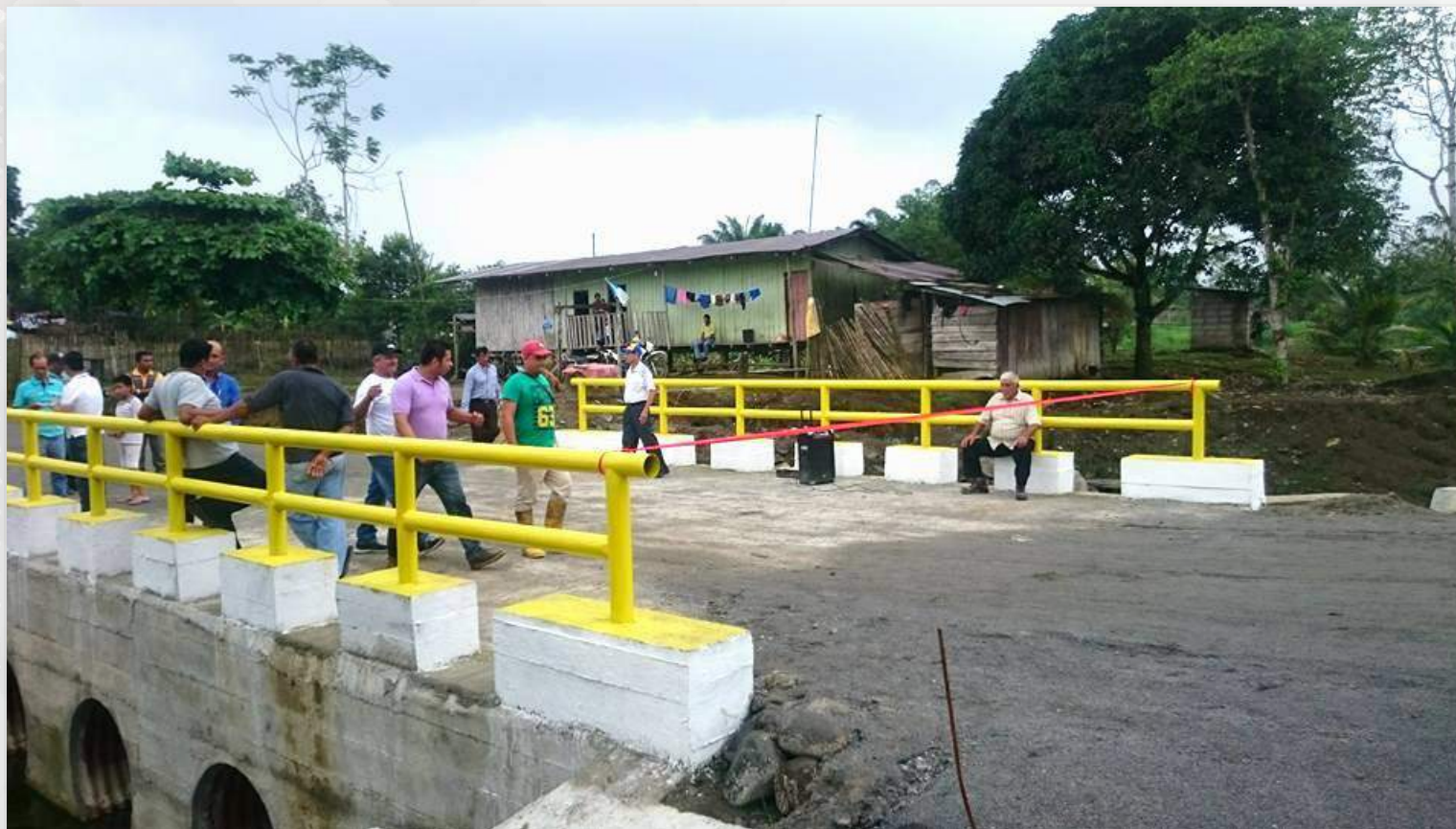
PUENTE EN COOPERATIVA 8 DE JULIO, GOLONDRINAS
