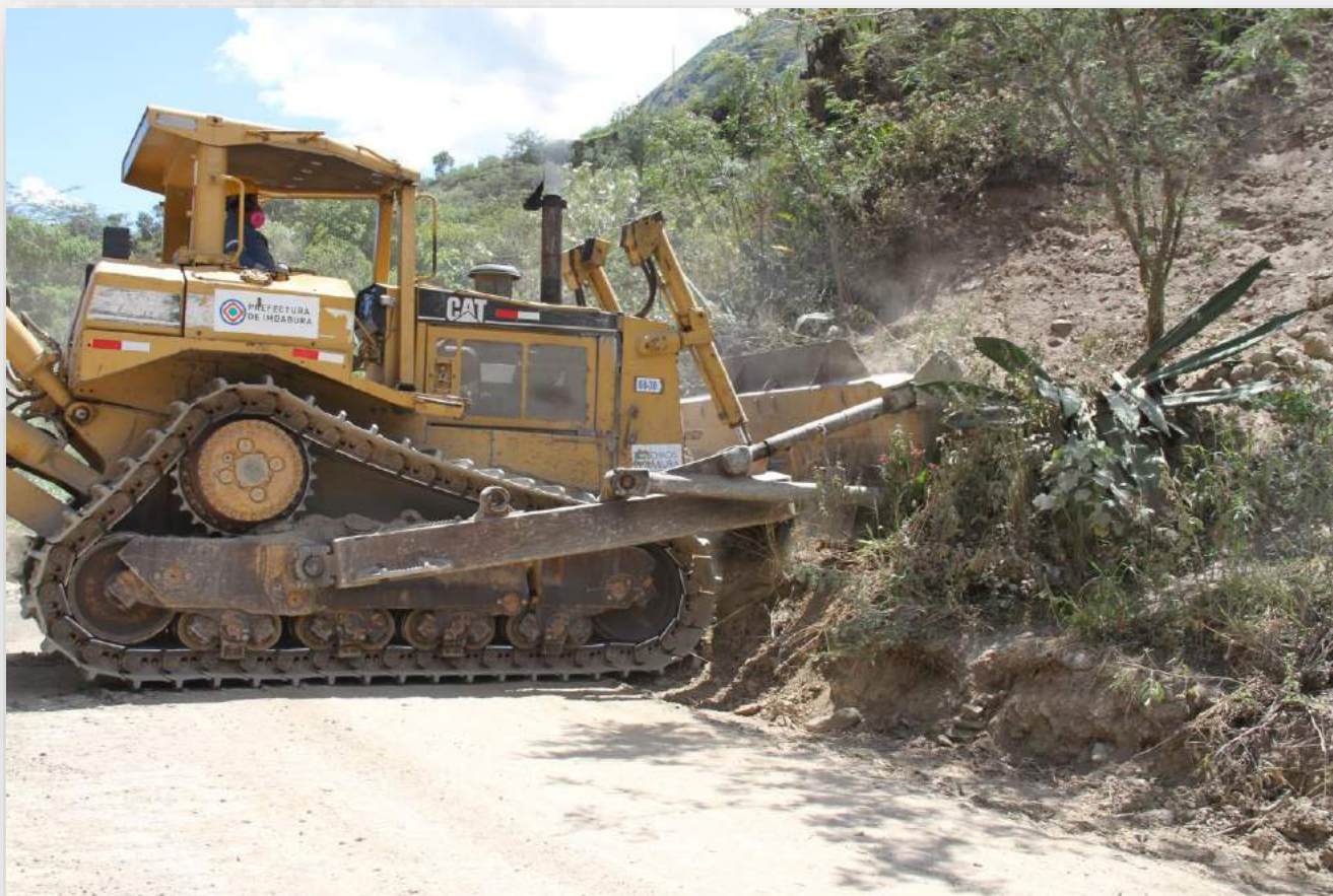
Maquinaria trabajando en Pimampiro
